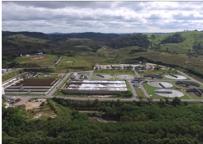
Estação de tratamento de esgoto - ETE Arrudas
