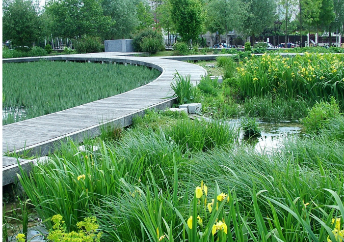
Sistema de tratamento de águas residuárias
